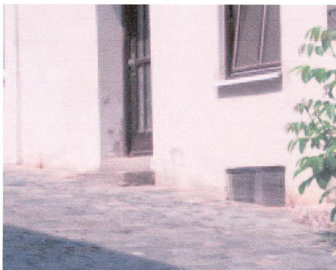
Sichtbare Mauerschäden durch aufsteigende Feuchtigkeit.
